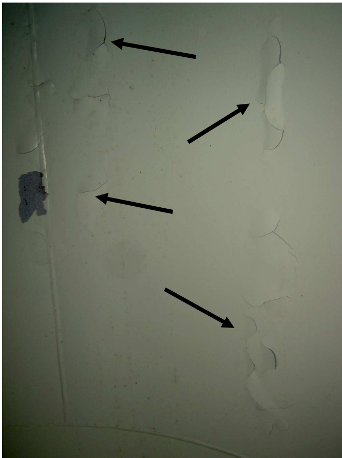
Verfhechting op mastwand
