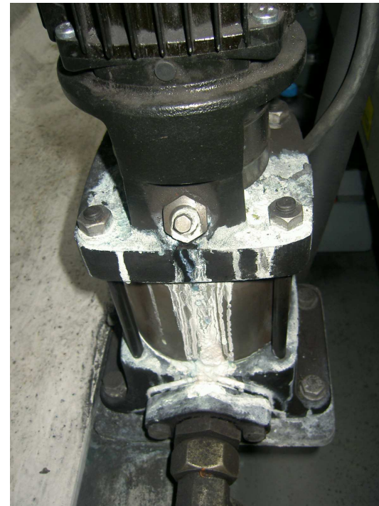
Lekkage koelwaterpomp
